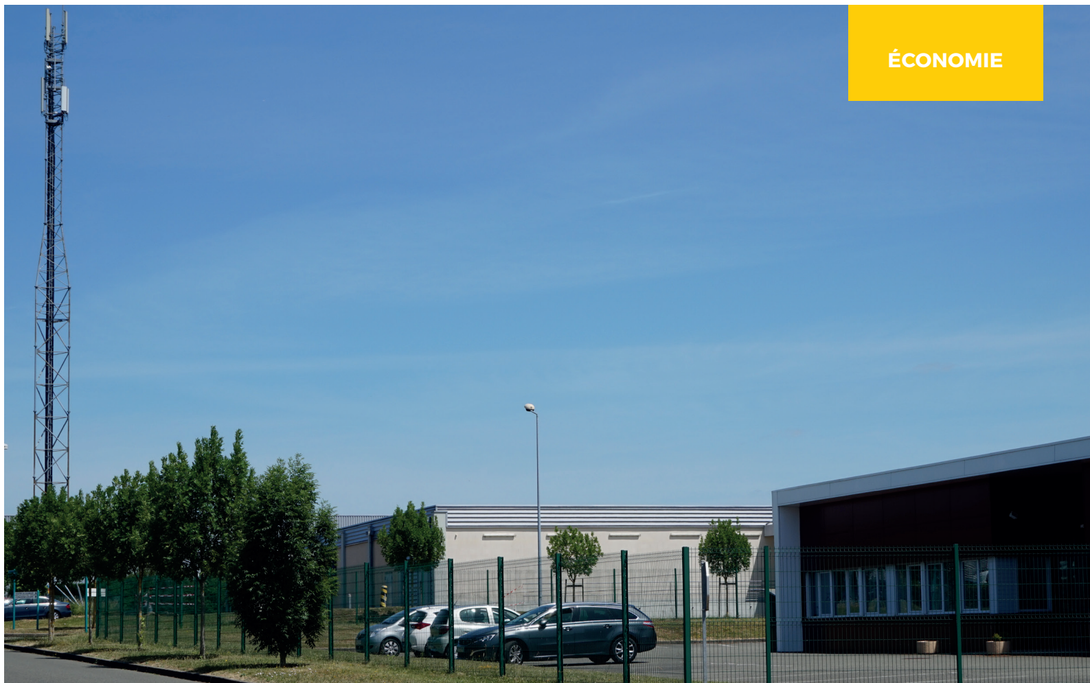
Zone d'Activités de Mont-sur-Loir Montval-sur-Loir
