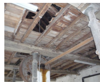
partie à rénover
